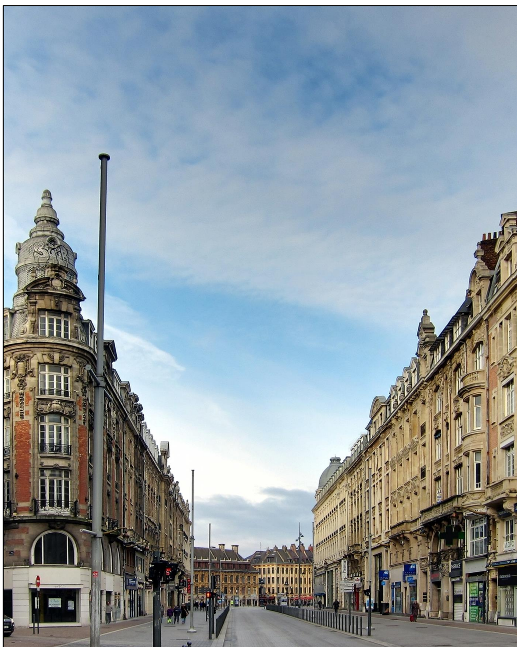
RUE FAIDHERBE Immeubles haussmanniens
